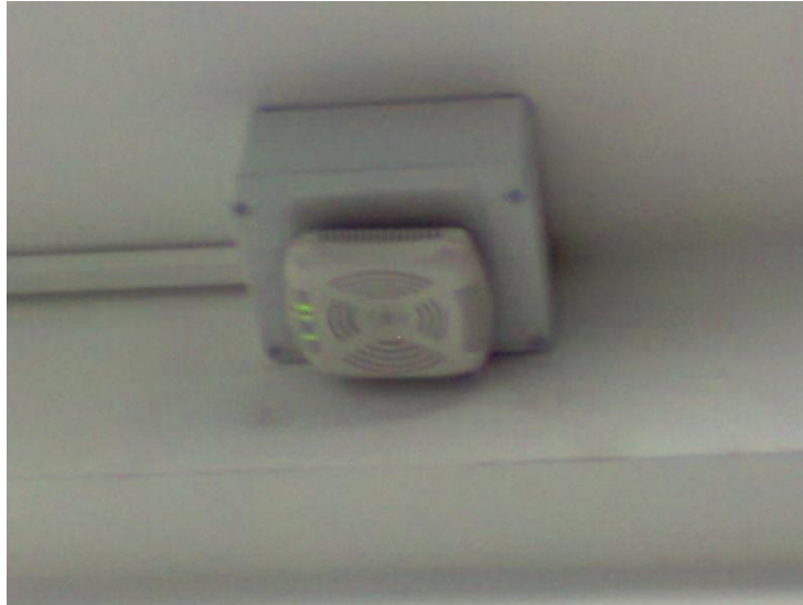
Figura 10. Fotografía del Access Point que cubre las áreas de Informática, Catastro y Teatro Municipal.
