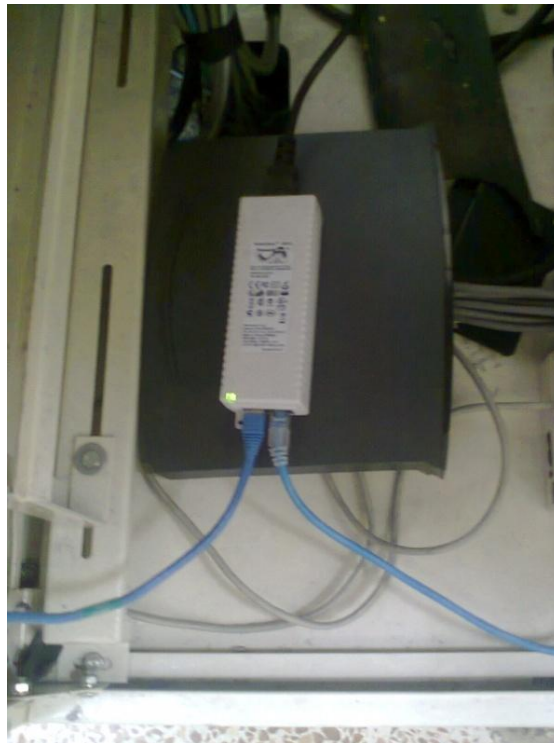
Figura 9. Fotografía del conector tipo PoE del AP presente en la Dirección de Informática que cubre las áreas de Informática, Catastro y Teatro Municipal.
