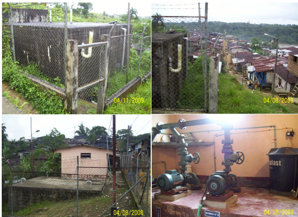
Figura 2. ETAP del acueducto del municipio de Lloró en la actualidad.
