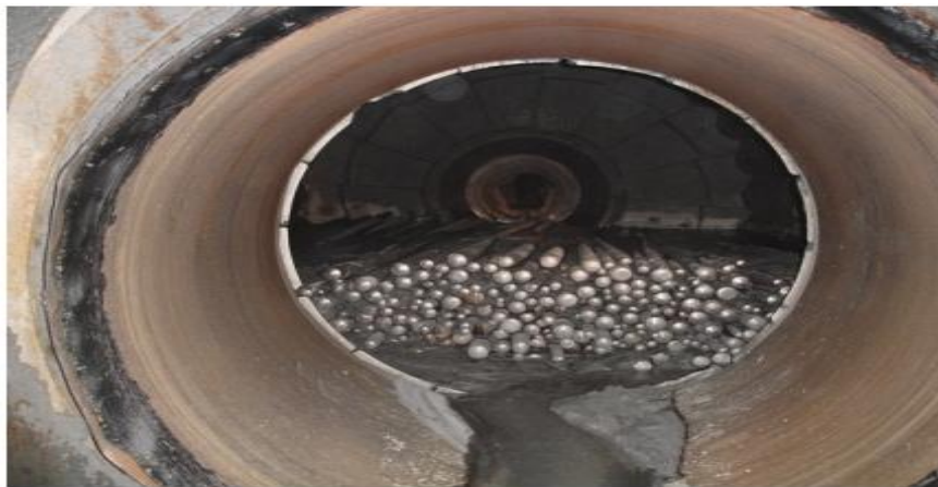
Figura 3. Parte interna molino de barras
