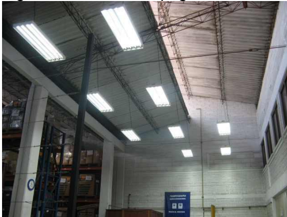
Figura 7. Área de tampografía
