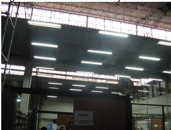
Figura 8. Taller de moldes y construcción mecánica
